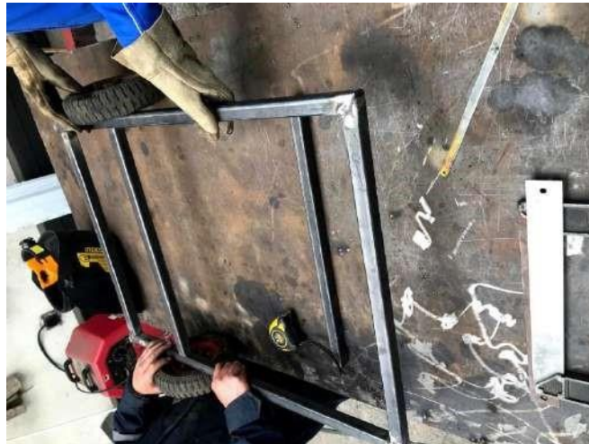
Figura 2. Construcción de la estructura base.
